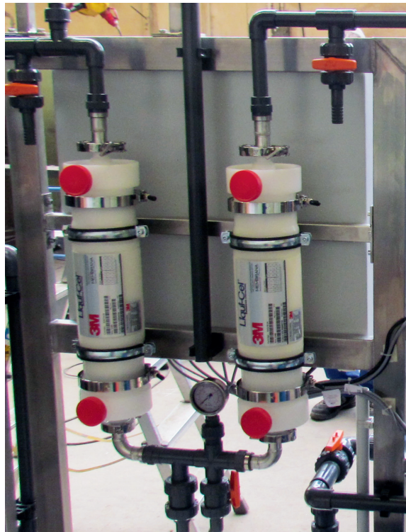
Anlegg i to linjer med membranavgassere
