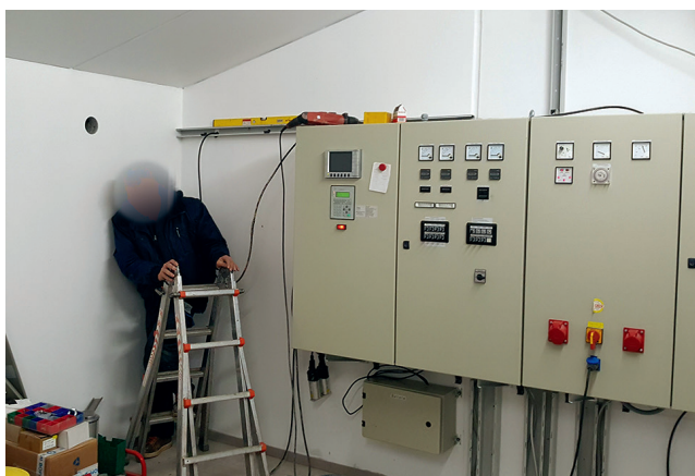
Montering av et koblingsanlegg ved våre medarbeidere
